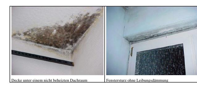
Häufig weisen die Konstruktionen bei Schimmelbefall Baumängel auf. Zur richtigen Beurteilung müssen diese aber in jedem Einzelfall genau untersucht werden.
